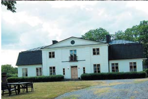
Herrgården på Siggesta har stått tom i 15 år och nu renoveras den tillbaka till ursprungligt skick.
