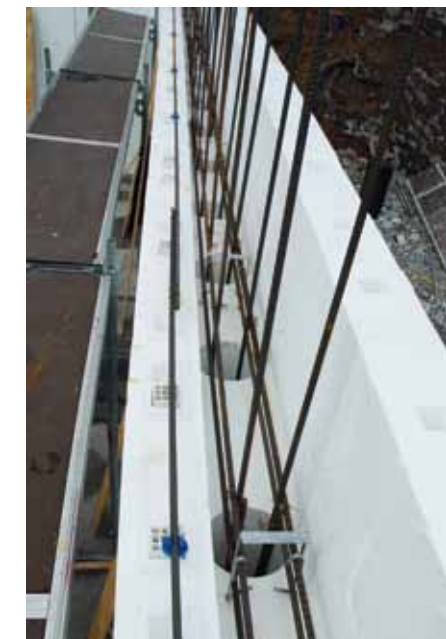
Här ser man frigolitblocken. Måtten på dem är 50x50x100. Hålen fyller man med betong och får då pelarna som håller upp betong golvet och övervåning.
